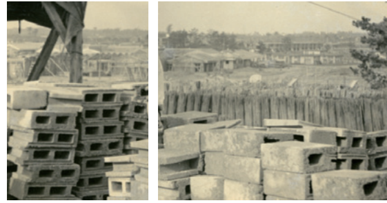
1951年当時の嘉手納基地内住宅工事の様子 沖縄市提供
