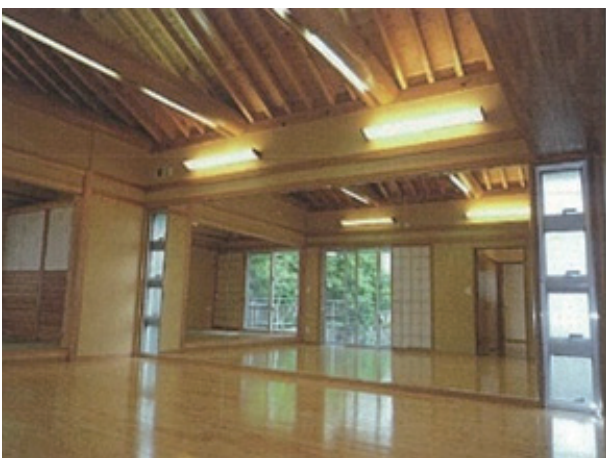
混構造の屋根（室内）
