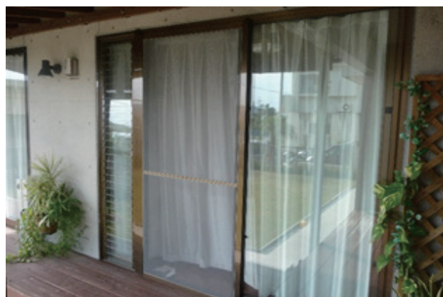
ジャロジー窓の設置
