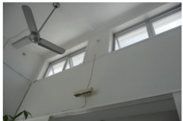
ハイサイドライト（間接的に屋光が室内に入る例）
