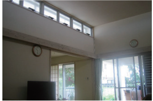
高窓（内部より）
