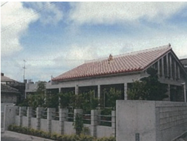
混構造の屋根（外観）
