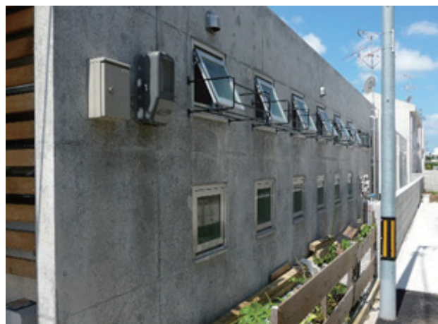
防犯に配慮した小窓の設置
