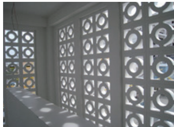
図 花ブロックを用いた採光の事例 (比屋根の集合住宅)
