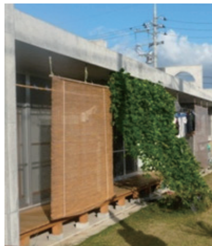
簾を内側から見る。このように開口部から離して設置すると風が通りやすい。
