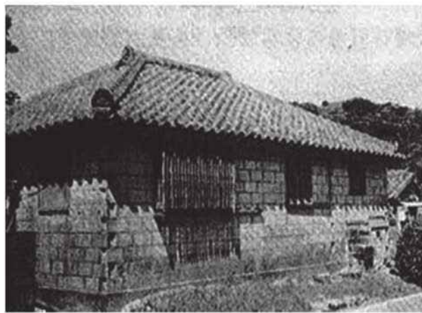
写真8 コンクリートブロック造木造小屋組瓦葺き住宅 ※米国立公文書館
