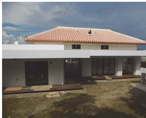
写真10 赤瓦の屋根をかけたRC造住宅
