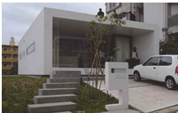
写真12 通風や遮熱を考えた現代RC造住宅
