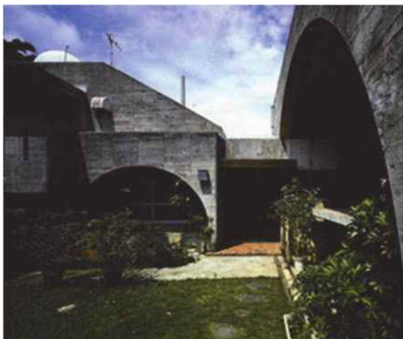
写真11 内部を木造としたRC造と木造の混構造住宅
