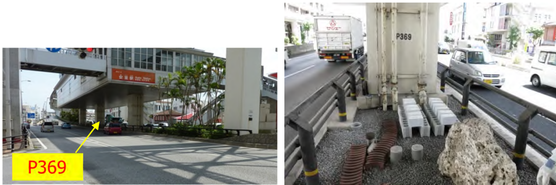
写真 3.7.1 中性化暴露試験状況
