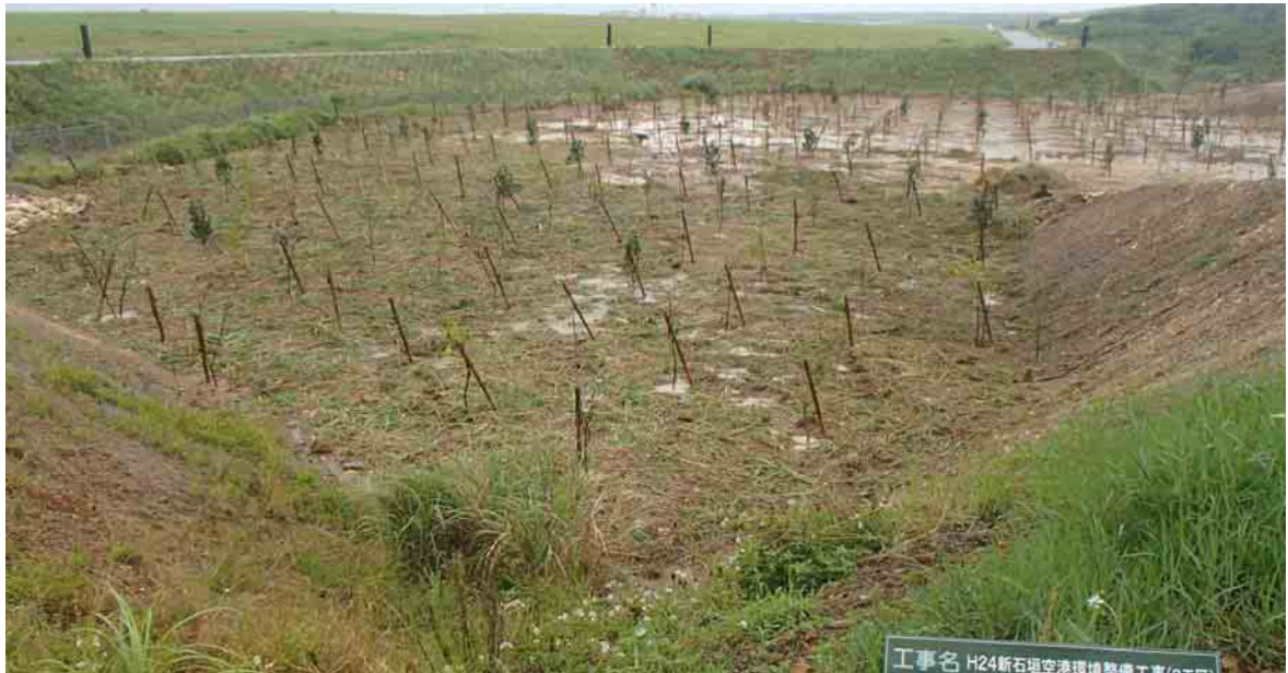
図 2.8.1 空港本体北側の植栽後（撮影：平成 25 年 3 月）
