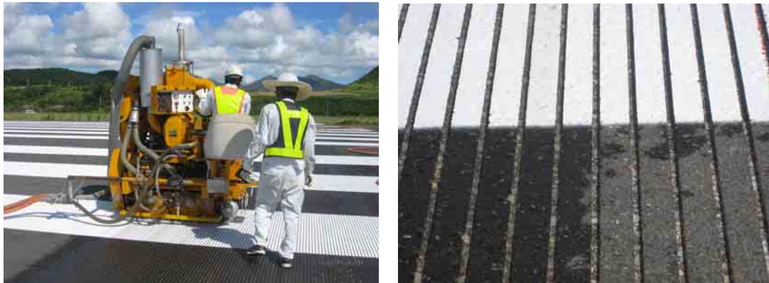
図 2.3.1 グルーピング工の施工状況
