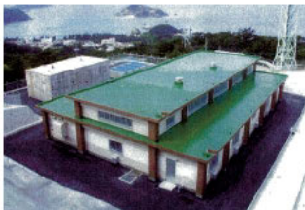
第三浄水場全景
