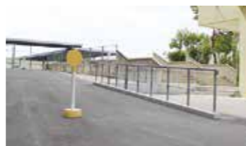
体育館前スロープ
