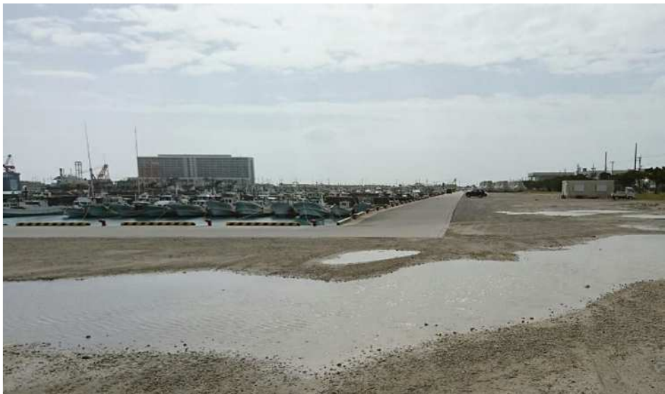
休憩岸壁背後に道路が整備されていないため、走行性が悪い状況（平成30年10月撮影）
