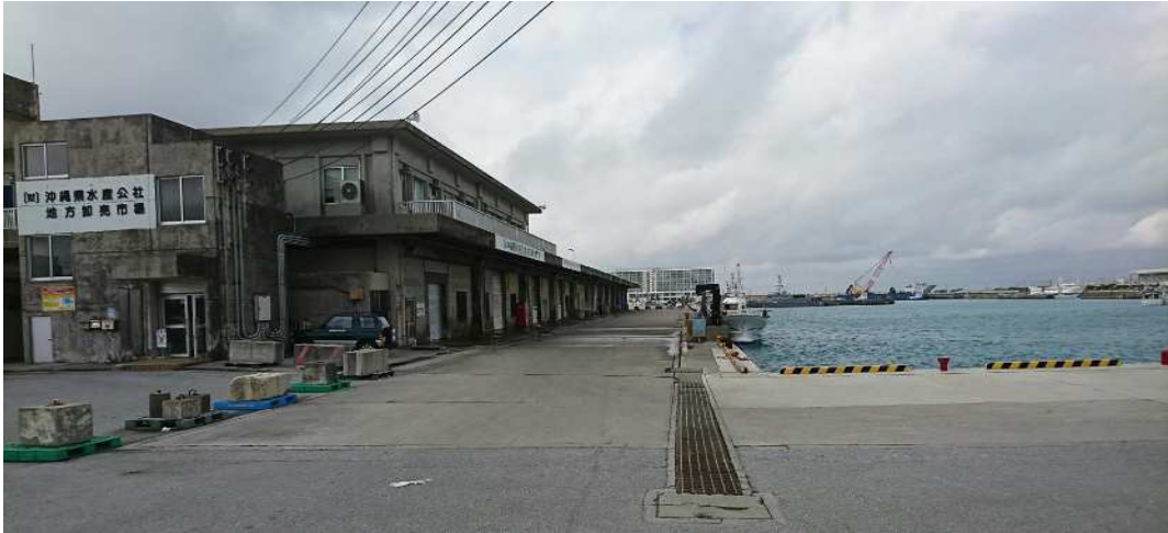
荷さばき施設全景（糸満漁港）（平成31年1月撮影）
