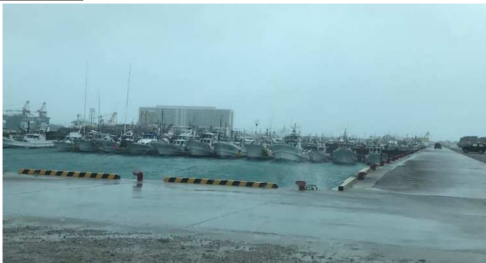
台風時における漁船の避難係留状況（波除堤から岸壁側に綱取り）（平成30年9月撮影）
