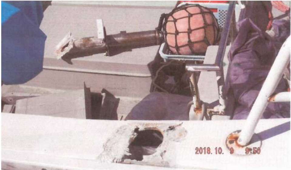
台風による漁船被害状況（右舷ビット破損）（平成30年10月撮影）
