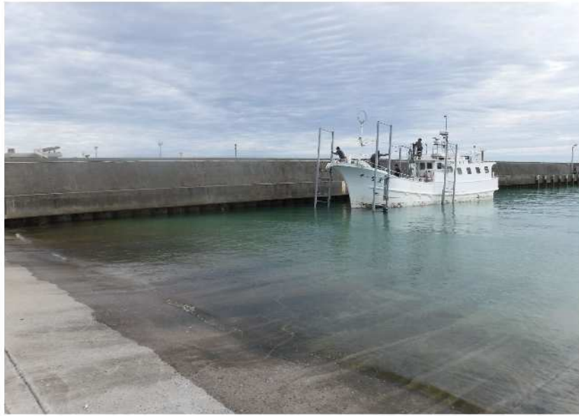
既設船揚場干潮時の潮待ち状況（糸満漁港南地区）（令和3年5月撮影）
