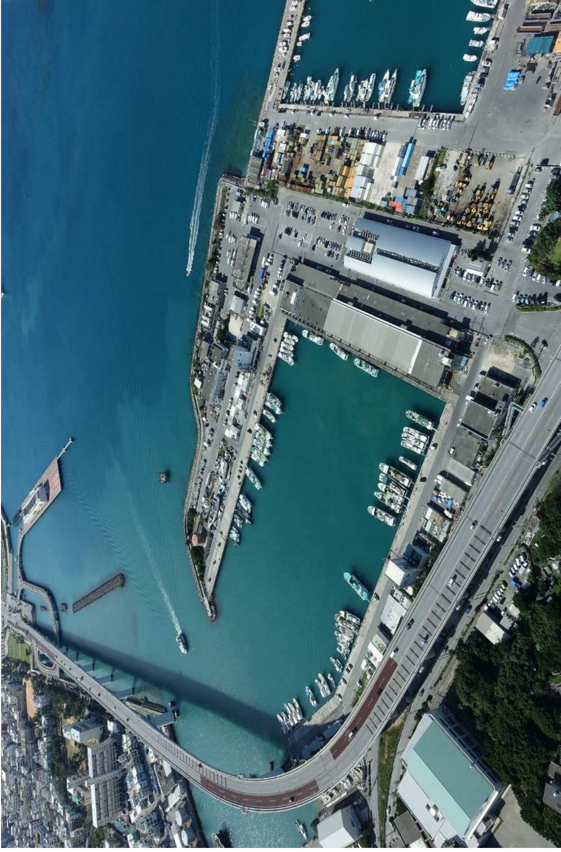
泊漁港(第2種漁港、沖繩県管理) 平成29年撮影
