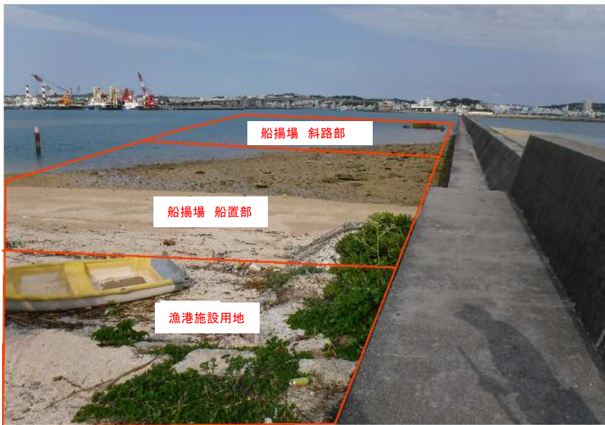
大型漁船用船揚場の新設箇所状況（糸満漁港北地区）（令和2年4月撮影）
