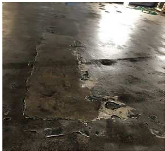
支柱の腐食（コンクリート剥離、鉄筋腐食） 床面のコンクリート剥離 荷さばき施設老朽化状況（糸満漁港）（平成31年1月撮影）
