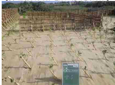
植栽工、防風工
