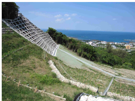
吹付法枠工、植栽工
