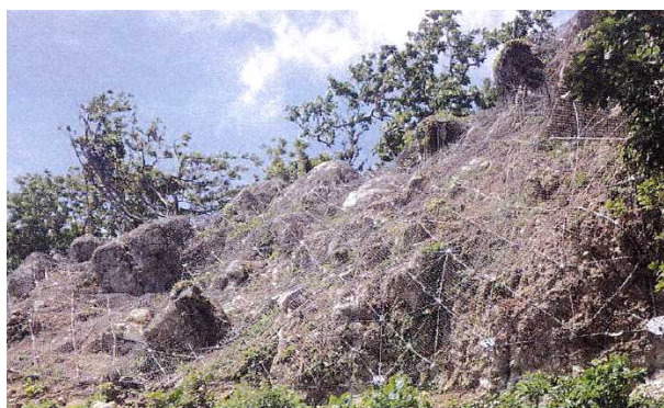
落石防止対策（工種：ロープ固定工）
