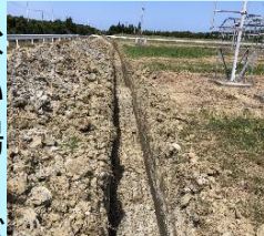
排水溝がない圃場では明渠を掘る
