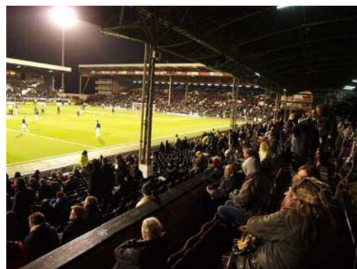
屋根を支える柱が立っている
