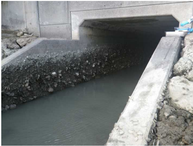
(St. 1 採泥箇所の直上の暗渠)
