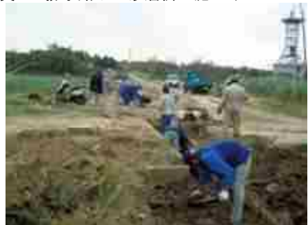
写真8 排水路や土砂溜樹の泥上げ
