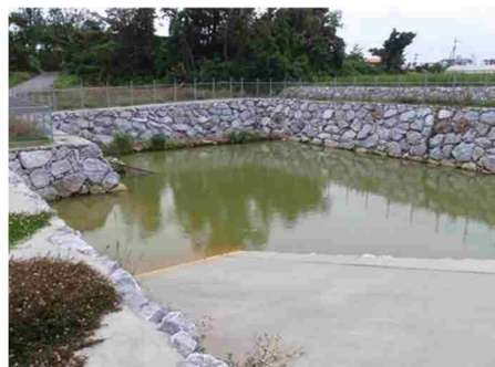
写真4 沈砂池
