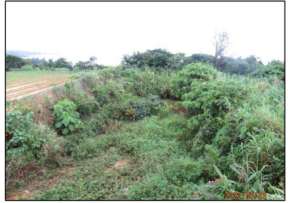
図-2.2.4 実証試験箇所（恩納村）
