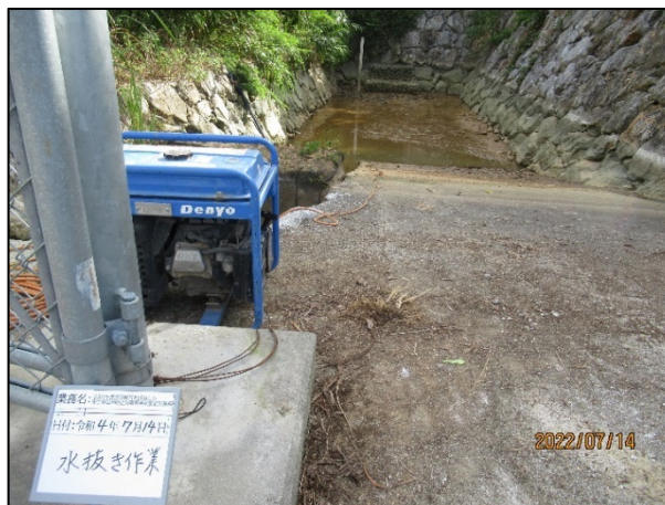
図-2.4.1 沈砂池の整地(水抜き作業)
