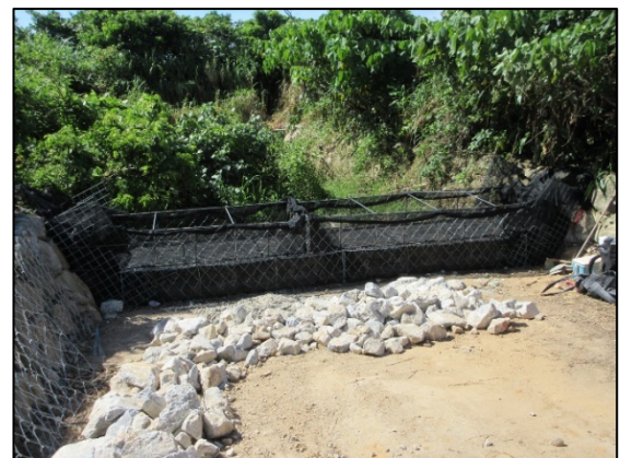
図-2.4.12 配筋によるフトン籠の補強 ※自立骨組として内側に補強や重しの目的も兼ねて鉄筋(D-16mm)を配筋した。
