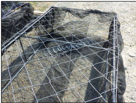
図-2.4.9 フトン籠・防風シート ※蛇籠に軽石流出防止用のネットを展張
