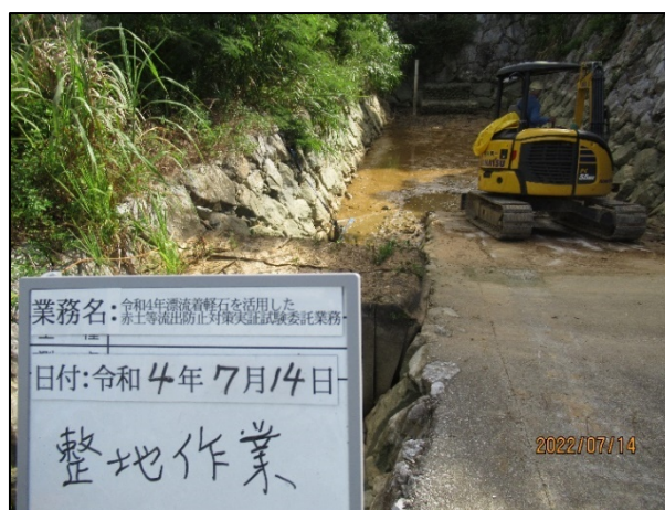
図-2.4.2 沈砂池の整地作業
