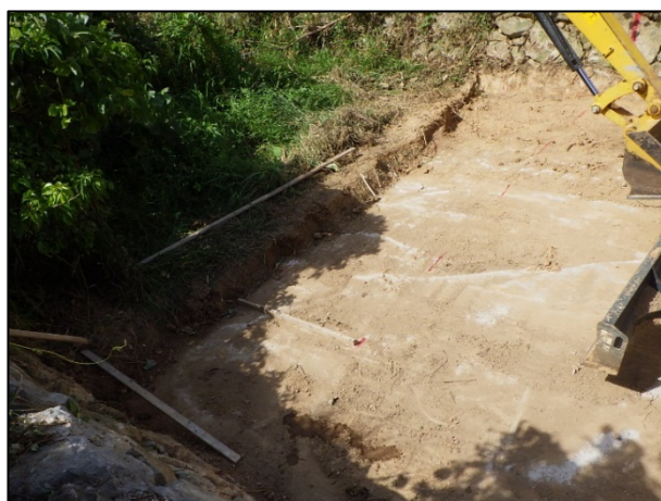
図-2.4.4 試験箇所の整地作業
