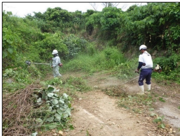
図-2.4.3 試験箇所の除草作業
