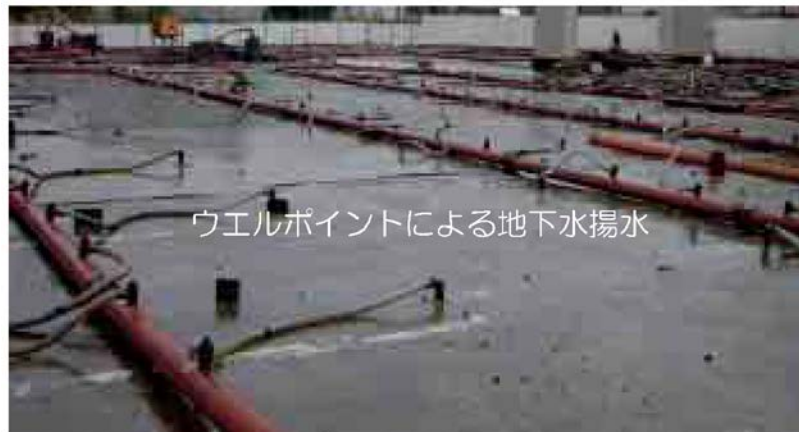
図 8-12 地下水揚水の概況写真
