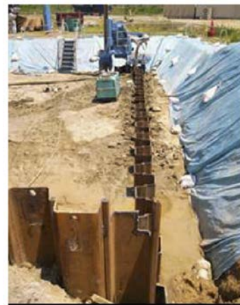
図8-20 遮水壁（鋼矢板）の打設状況
