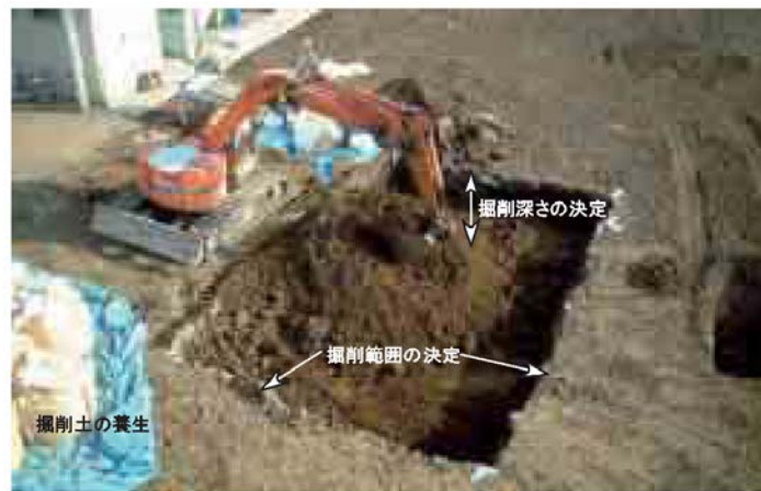
図 8-14 掘削除去の概況写真
