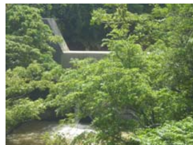
写真 砂防施設
