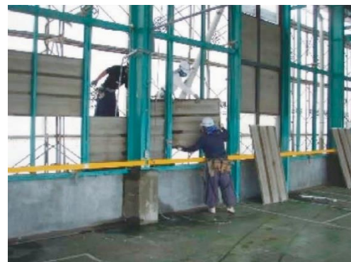
壁石綿含有成形板取外し
