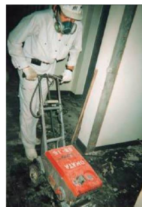
図4.11.12 石綿含有ビニル床タイルの 除去例
