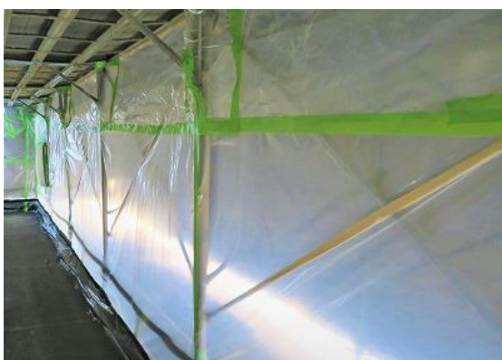
周囲への飛沫飛散防止養生例（内部）
