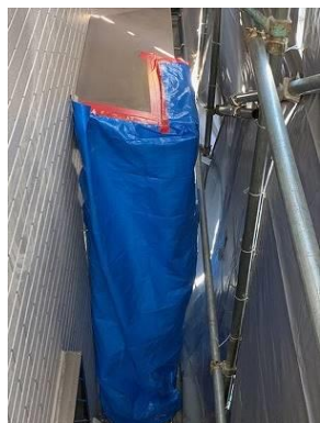
④下屋の端部での隔離養生の外観。
