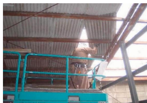
屋根スレート取外し
