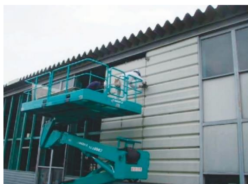
壁金物取外し
