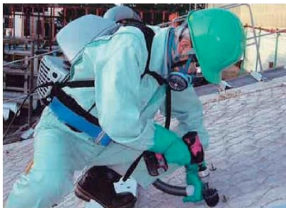
粉じん回収（高性能真空掃除機）
