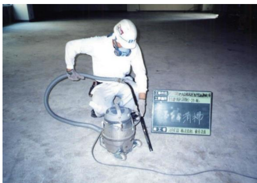
図4.11.21 清掃 高性能真空掃除機使用例
