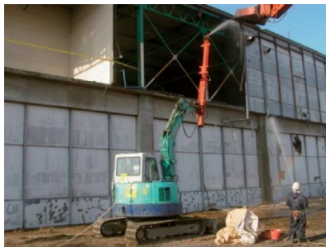
図4.11.5 湿潤化の例 （作業内容に応じて立入禁止措置や掲示を行うこと）
