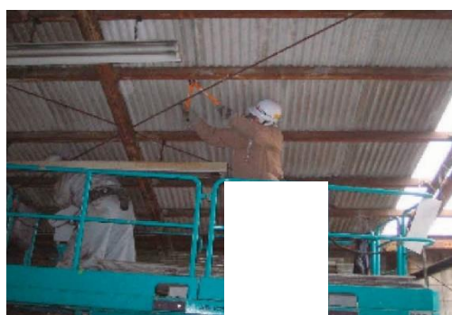
屋根スレート止め金物切断
